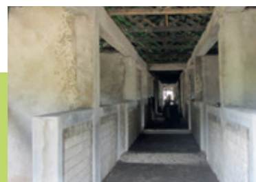
Etwas weiter gediehener Rohbau. Nach langem Hin und Her hat sich Baupolier Paul Mwaura durchgesetzt: Die bis zur Decke hochgezogenen Seitenwände verleihen den Schlafabteilen doch eine gewisse Geschlossenheit. Türen sind keine vorgesehen.
