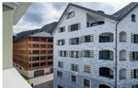
▲ Neubau Apartmenthäuser Wolf und Edelweiss, Andermatt
