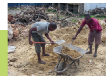
2020 . Baustart des Dormitoriums.
