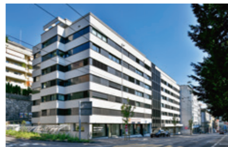
▲ Umbau Wesemlinstrasse, Luzern
