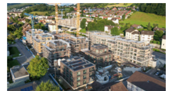
▲ Überbauung St. Klemens, Ebikon: die Solaranlage, welche auf den Dächern montiert wird, wird ein Teil der benötigten Energie selber produzieren.
