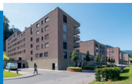
Luzern, Überbauung Cheerstrasse 13a-i
