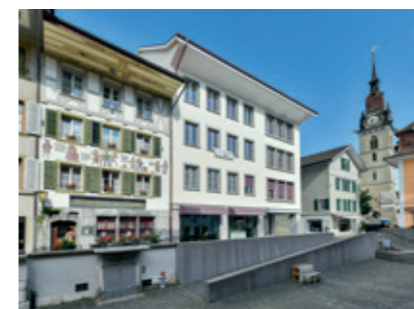
▼ Die historische Aussenfassade nach der Totalsanierung.
