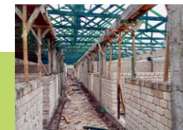
Die Mauern der Schlafabteile beidseits des Korridors dürften gemäss staatlicher Vorgaben nicht höher sein als 150 cm, um die Aufsicht der Mädchen zu gewährleisten. Die Dachträger sind vor dem Einbau mit einer grünen Chemikalie gegen Termitenfrass behandelt worden.
