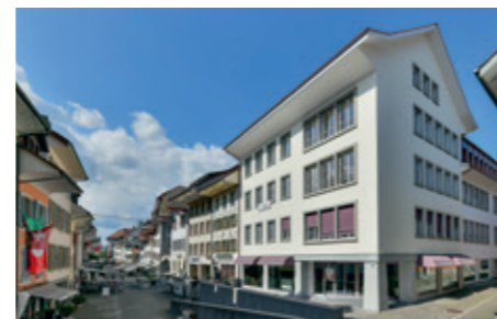
▲ Umbau Vordere Hauptgasse 33, Zofingen
